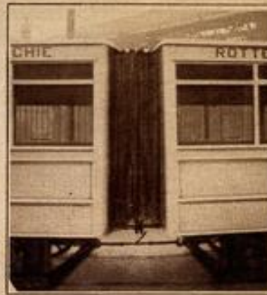
De verbinding tusschen de beide wagens, die herinnert aan het harmonika-systeem van onze D-treinen.
